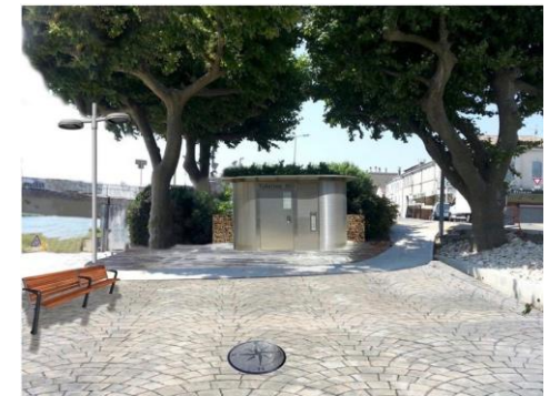
Aire de service Viarhona – Bourg-Saint-Andéol
